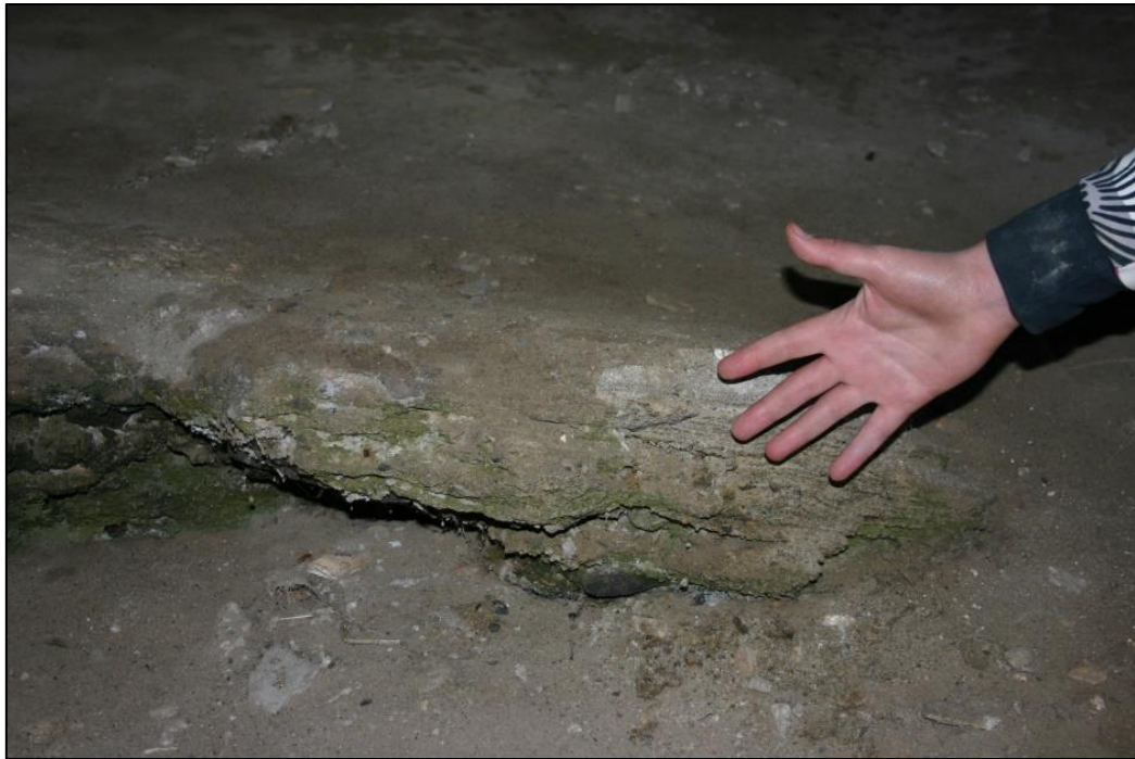
Échantillon ASAR110_008 : galerie de la Mamelle, au niveau d'une petite niche à gauche de l'éboulis. Le matériel est très fin et induré. L'altération en boules est présente et un niveau plus grossier bien induré scelle ce dépôt. Photo P. Sorriaux.
